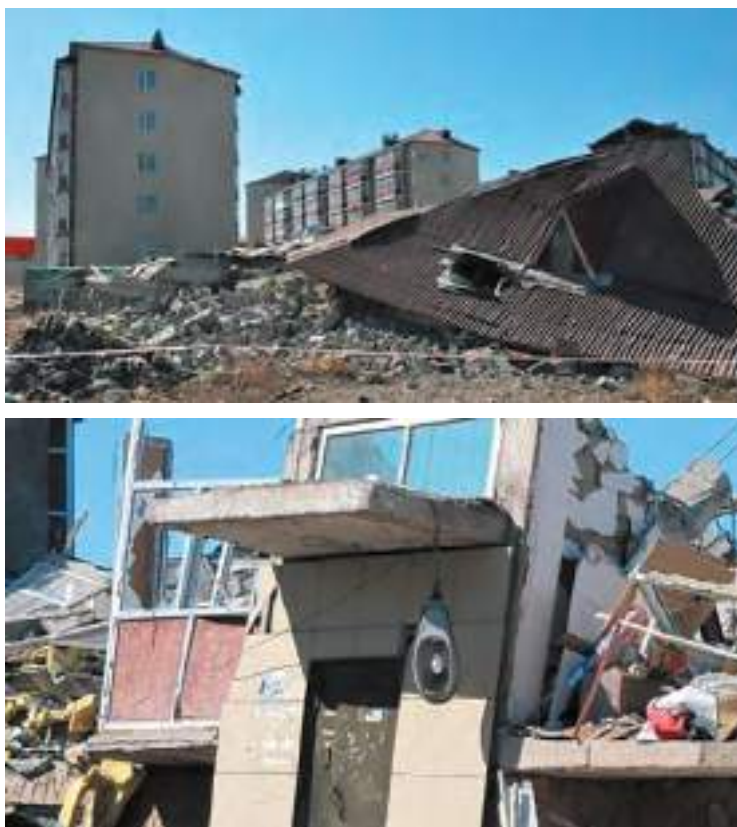
Fig. 4.6.10. The collapse of a house in the residential complex “Besoba” in Karaganda, Kazakhstan http://s019.radikal.ru/i613/1205/a4/b3929a7421cb.jpg http://s53.radikal.ru/i142/1205/8a/c26eefc4118d.jpg
